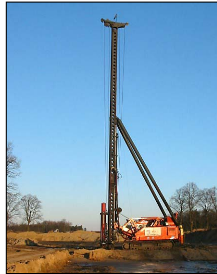
Fot. 1. Wolnospadowe palownice hydrauliczne do wbijania pali prefabrykowanych.
