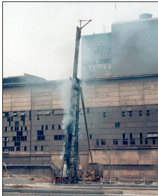
Fot. 2. Palownice Fundex z kafarem spalinowym Delmag do wbijania pali Vibro, Vibrex i prefabrykowanych.
