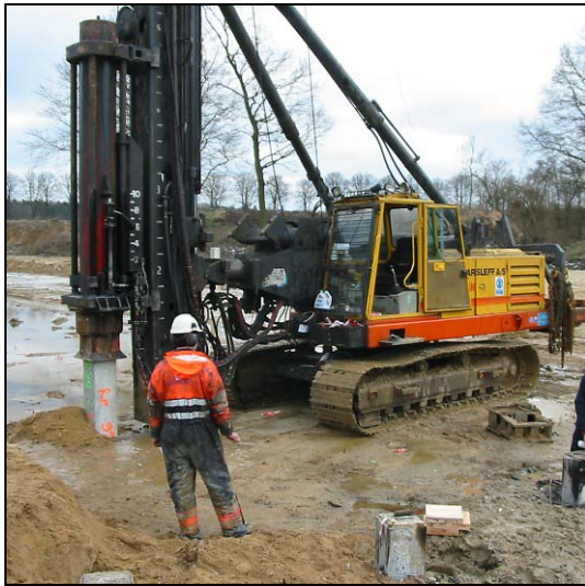
Fot. 1. Wolnospadowe palownice hydrauliczne do wbijania pali prefabrykowanych.
