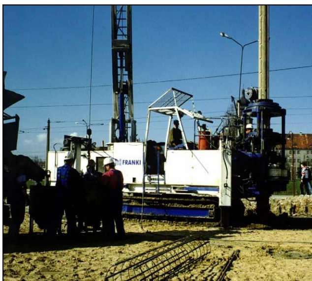
Fot. 5. Palownica do pali „Atlas” oraz widok głowicy pala „Atlas”
