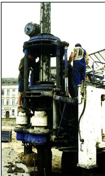
Fot. 5. Palownica do pali „Atlas” oraz widok głowicy pala „Atlas”
