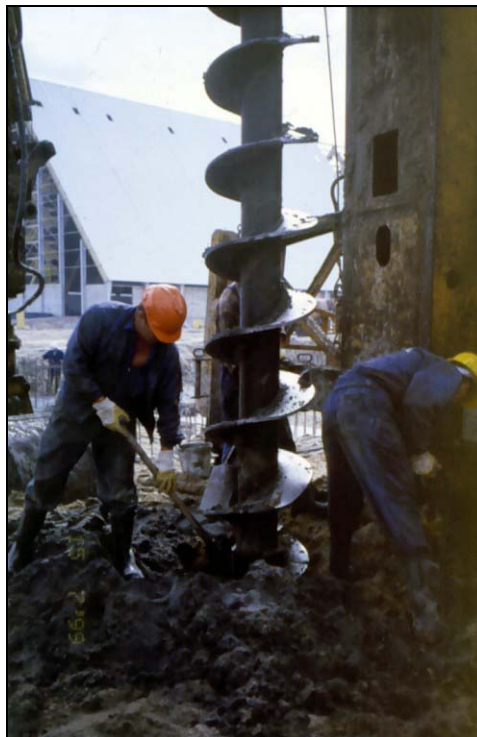
Fot. 4. Palownice do pali wierconych świdrem ciągłym „CFA”
